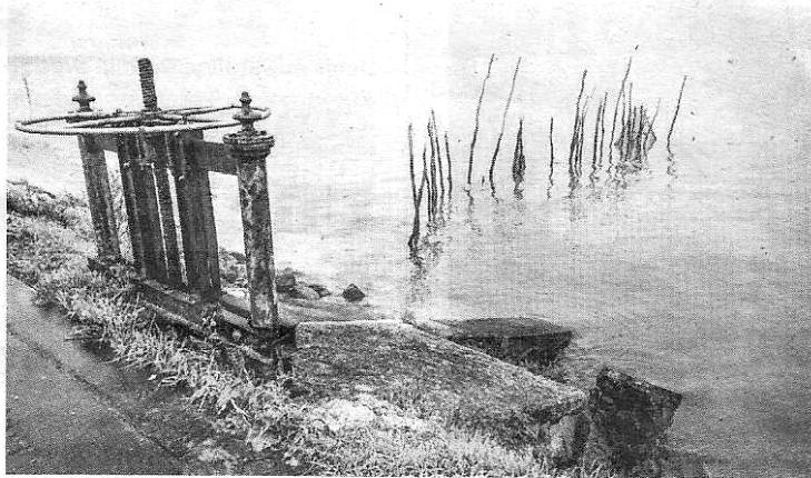
L'entrée de l'ouvrage de la maline, côté prés-salés Est à La Teste.
